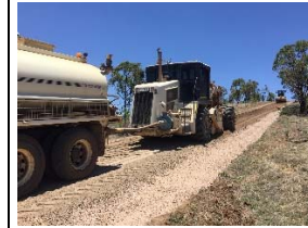
In situ Stabilisation
